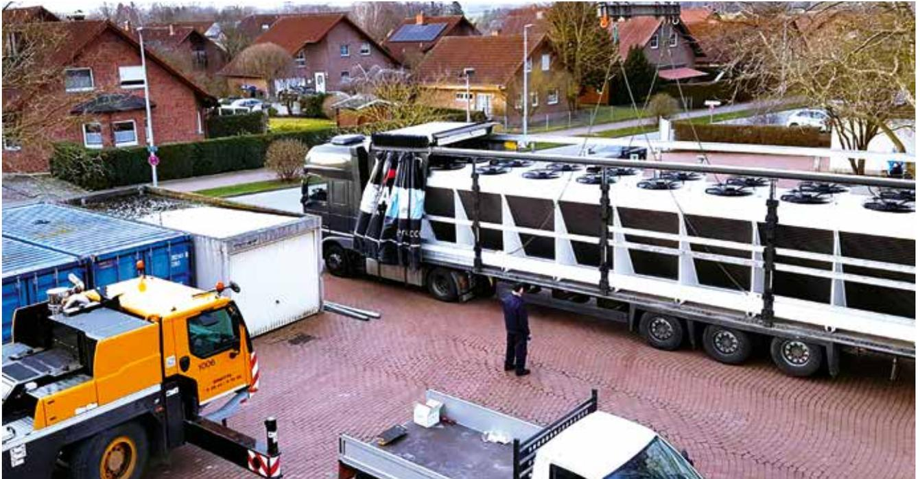
So sieht es aus, wenn 7,5 Tonnen millimetergenau bewegt werden. Hintergrund für diese Aktion war der Austausch der Kältezentrale des Klinikums – inklusive entsprechender Rückkühlung auf dem Dach. Die alte Kältezentrale war mittlerweile knapp 20 Jahre alt, Reparaturen daran nicht mehr wirtschaftlich.
